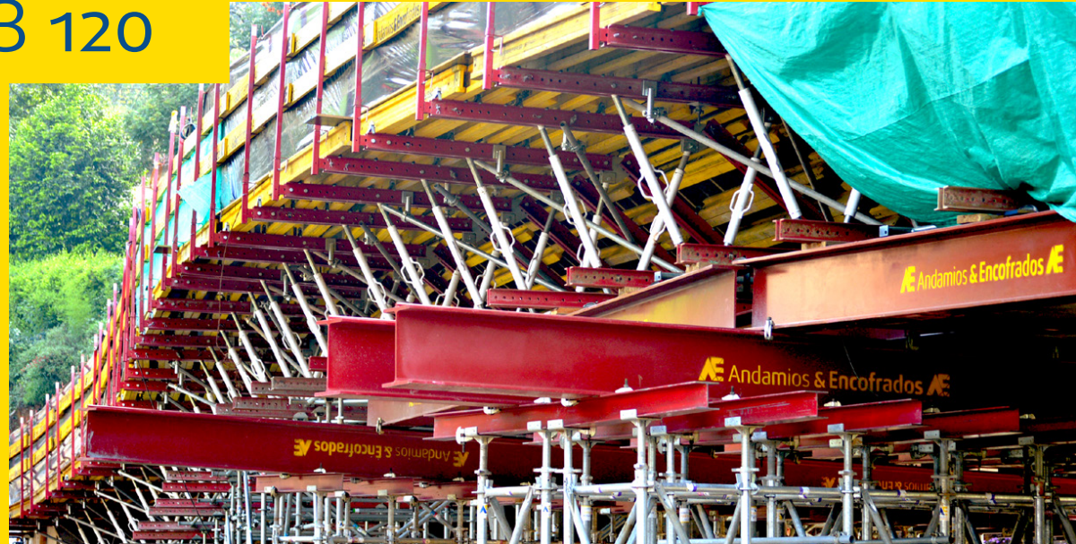
Puente Transversal Inferior con Calle 10 Medellín - Antioquia
